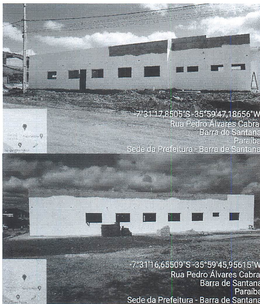
Figura 2: Prefeitura em Execução - Parte Laterais
