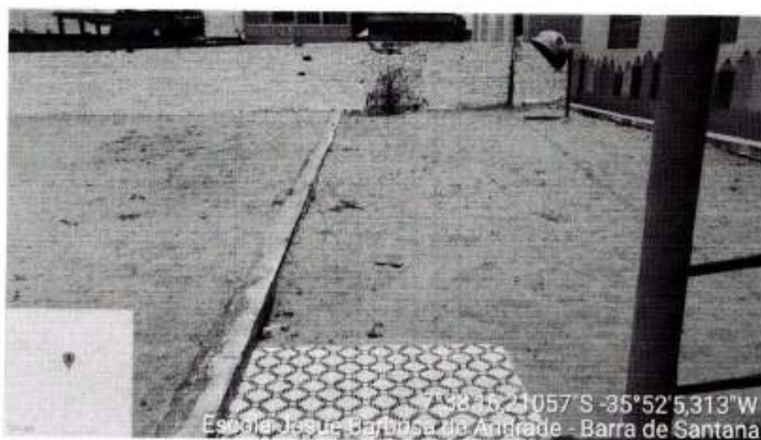
Figura 2: Local Onde será o Pátio
